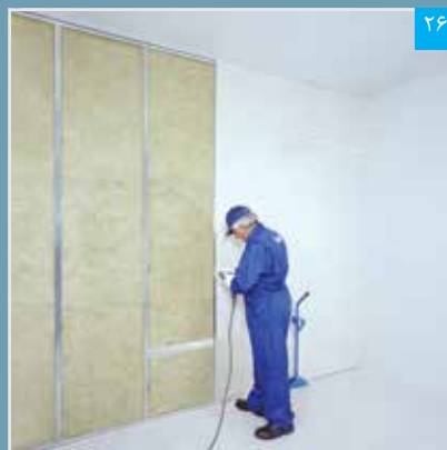
اجرای پنل ها در طرف دیگر دیوار (پنل ها نسبت به سمت اول به صورت حصیر چین اجرا می شوند)
