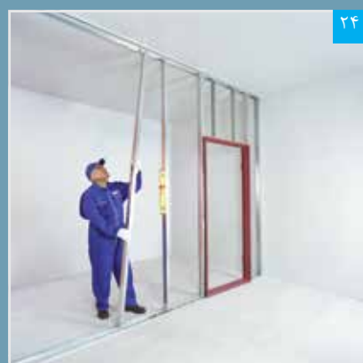
اجرای استادهای دیوار
