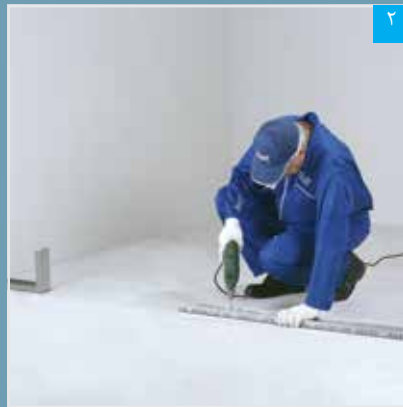
۲ نصب رانر کف
