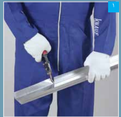
۱ برش انتهای رانرهای کف (در محل بازشوی در) به اندازه ۲۰ سانتیمتر
