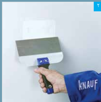
۲ اجرای بتونه بر روی وصله ترمیمی
