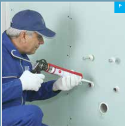
۶ اجرای خمیر درزبند در اطراف خروجی‌های تاسیساتی
