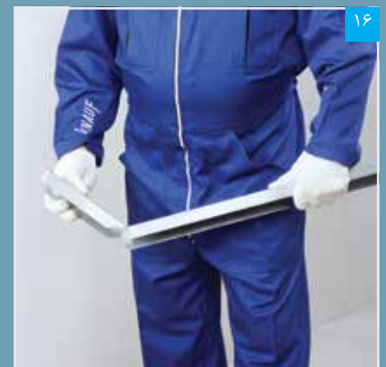
۱۶ خم کردن انتهای رانر نعل درگاه
