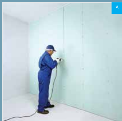
اجرای لایه دوم پنل‌ها (لایه دوم نسبت به لایه اول به صورت حصیرچین اجرا می‌شود)
