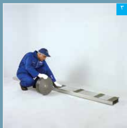
اجرای نوار عایق بر روی استاداها
