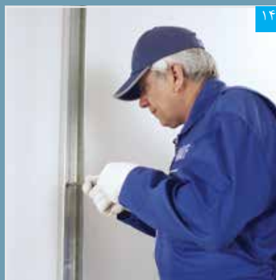
اتصال استاد به دیوار بنایی با رول پلاگ
