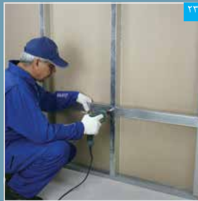
اجرای سازه پشت بند در محل درز افقی
