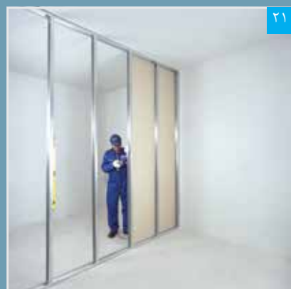
اجرای پنل‌ها در یک طرف دیوار
