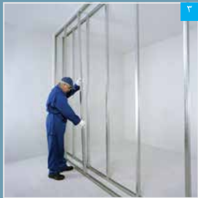
اجرای ردیف دوم استاداها
