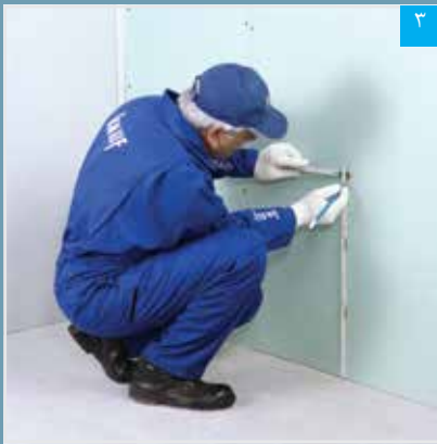
۳ تعیین محل خروجی‌های تاسیساتی
