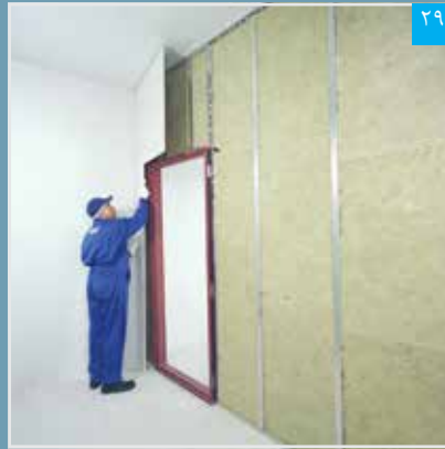
اجرای پنل سوم دور چهارچوب پس از عایق گذاری (پنل هانسبت به سمت اول بصورت حصیر چین اجرامی شوند)
