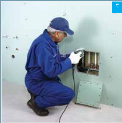
اتصال قاب دریچه
