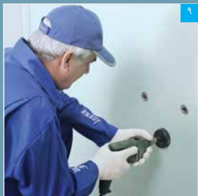
خروجی‌های تاسیساتی به وسیله گردبر ایجاد می‌شوند
