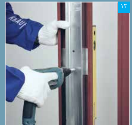
۱۳ چهارچوب توسط پیچ LB در محل صفحات نصب به استادها متصل می‌شود
