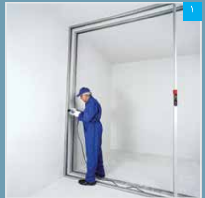
دو ردیف قاب با فاصله از یکدیگر اجرا می‌شوند (فاصله قاب‌ها به حجم تاسیسات بستگی دارد)
