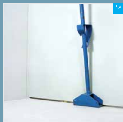
پنل‌ها بوسیله جک مخصوص به نحوی بر روی زیرسازی قرار میگیرند که ۱ سانتیمتر با کف فاصله داشته باشند
