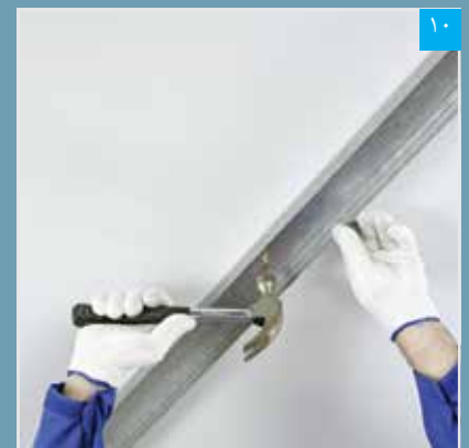
۱۰ اتصال رانر به سقف با رول پلاک
