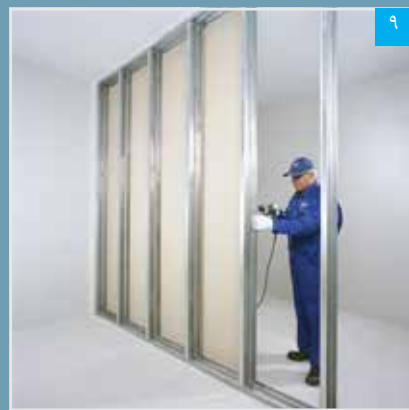
اجرای پنل‌ها در یک طرف دیوار
