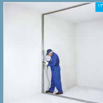
نصب استاد بر روی ساختار جانبی (سوراخ کردن استاد و دیوار)
