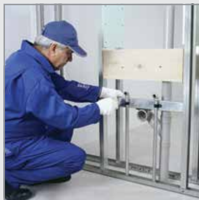
اتصال لوله‌های تاسیساتی به سازه پشتیبان SP60
