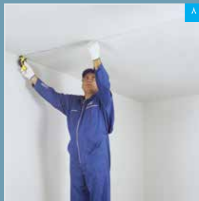
۸ مشخص کردن محل نصب رانر سقف با ریسمان رنگی
