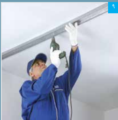
۹ نصب رانر سقف (سوراخ کردن رانر و سقف)
