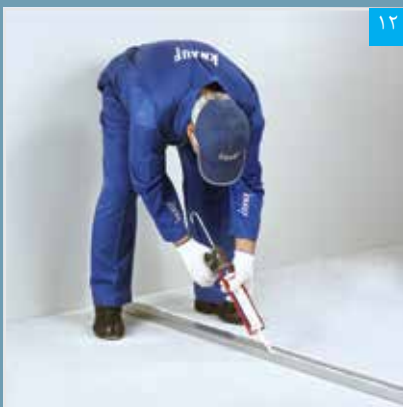
۱۲ اجرای دو ردیف خمیر سیلیکون (یا نوار عایق) بر پشت جان استادهای جانبی
