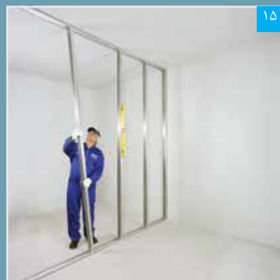
اجرای استادها (به صورت شاقولی)
