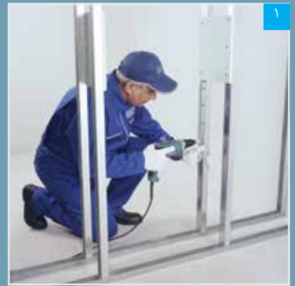
۱ اتصال قطعات نبشی L25 به استادهای مجاور
