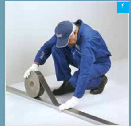
۴ اجرای نوار عایق (یا دو ردیف خمیر سیلیکون) بر پشت جان رانر کف و سقف
