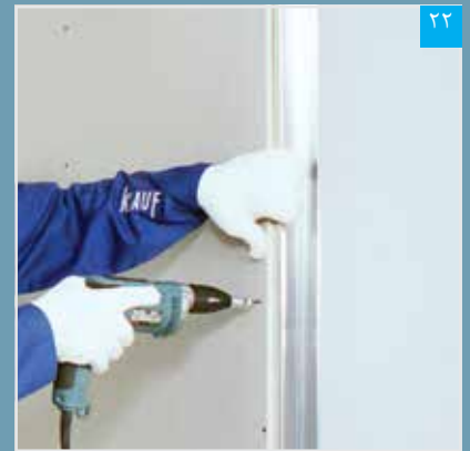
پنل باید در جهتی نصب شود که لبه آزاد آن به سمت دهانه باز استاد قرار گیرد
