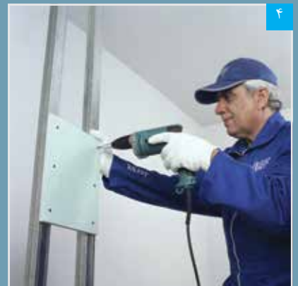
استادهای ردیف اول و دوم به وسیله برش‌هایی از پنل به یکدیگر متصل می‌شوند
