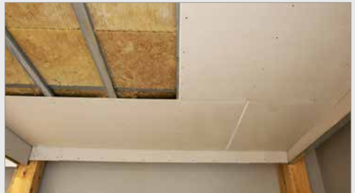
عایق کاری سقف ساختمان
