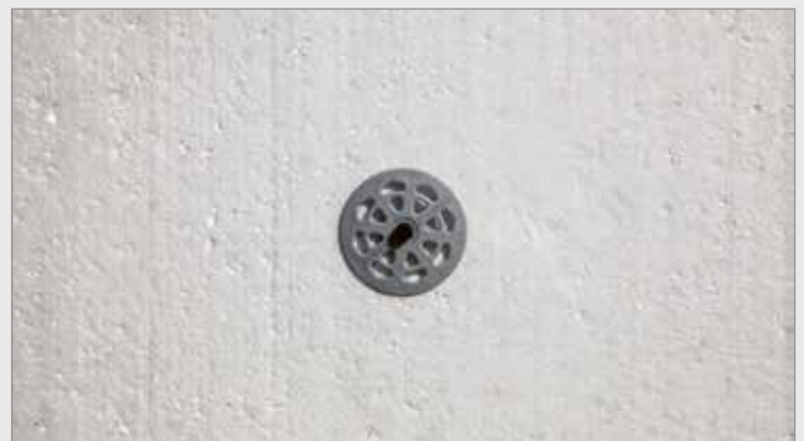
نصب بست‌های Termofix
