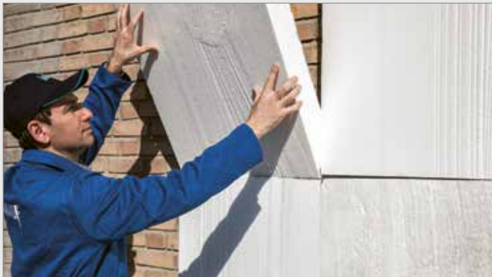
نصب قطعات عایق بر روی دیوار زمینه
