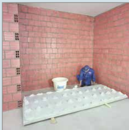
نشان دادن چانه‌های پرفلیکس بر روی پنل‌ها
