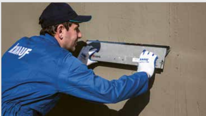
اجرای اندود SM700
