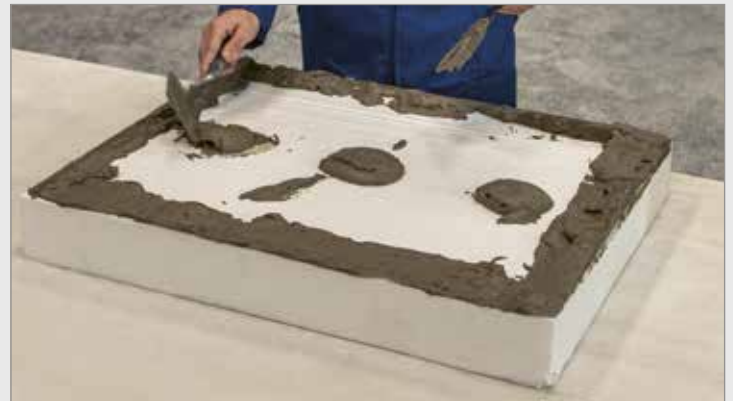
نشاندن چانه‌های SM700 بر روی قطعات عایق
