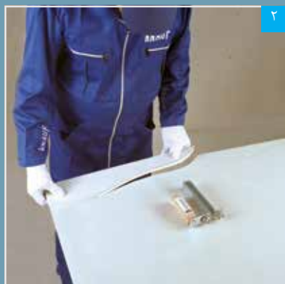
جداکردن پنل از محل برش
