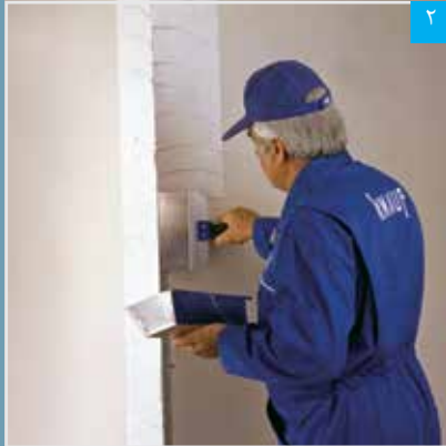
اجرای بتونه روی سازه محافظ گوشه
