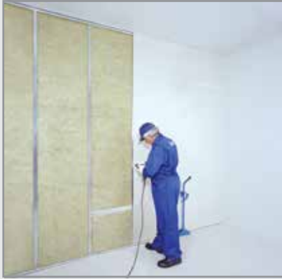
نصب پنل بر روی زیرسازی، با استفاده از جک و پیچ زن
