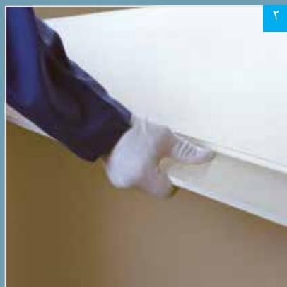
شکستن پنل در محل برش
