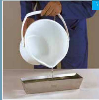
ریختن آب در ظرف تهیه بتونه
