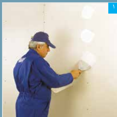
اجرای بتونه در محل پیچ‌ها
