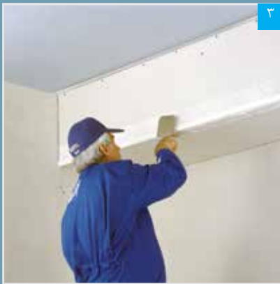
۳ تثبیت و شکل دهی نوار درزگیر با کاردک زاویه خارجی
