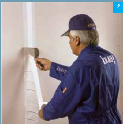
۶ قرار دادن نوار درزگیر بر روی بتونه
