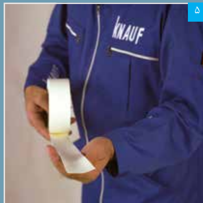
۵ مقطع نوار درزگیر (به انحنای آن توجه شود)
