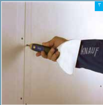
۳ فرو بردن سر پیچ‌ها با پیچ گوشتی پشت کاردک
