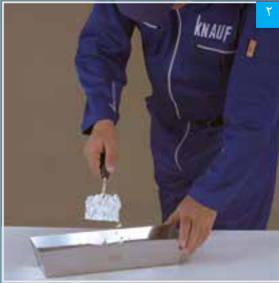
ریختن پودر بتونه در آب
