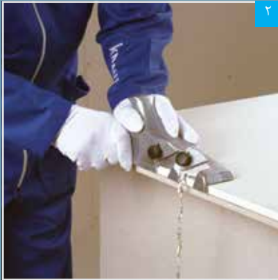
اجرای پخ با پخ زن
