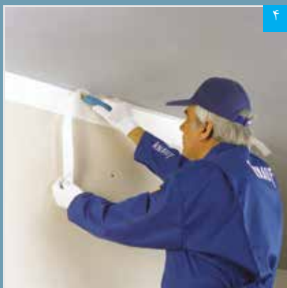
برش اضافات نوار چسب جداکننده پس از خشک شدن بتونه
