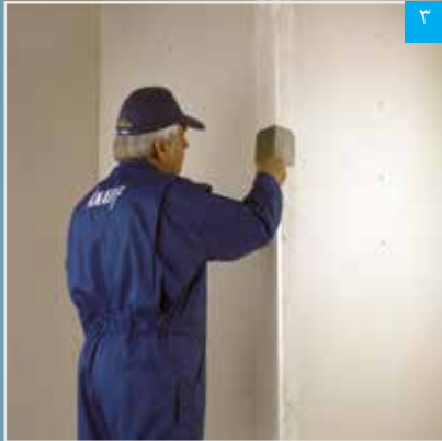
تثبیت و شکل دهی نوار محافظ گوشه با کاردک زاویه خارجی
