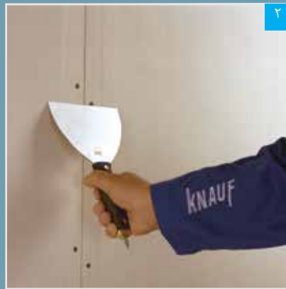
۲ بررسی بیرون زدگی پیچ‌ها با کاردک
