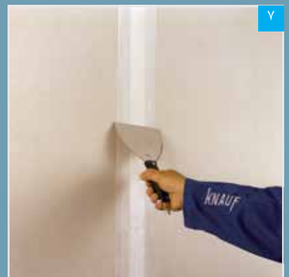
۷ مرطوب کردن سطح نوار با بتونه‌های اضافه
