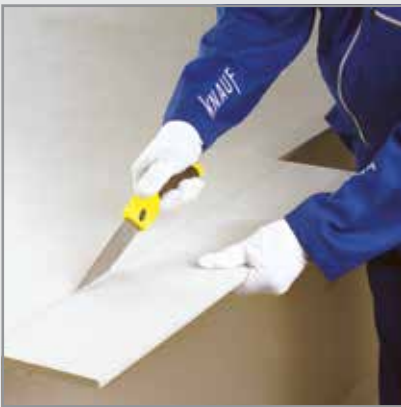
برش پنل با ااره دستی
