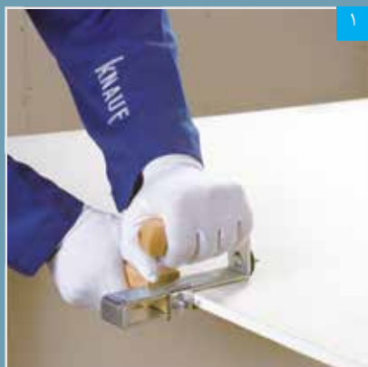
برش پنل با دستگاه برش قرقراهی
