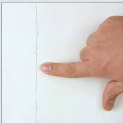
ایجاد ترک در اثر عدم استفاده از نوار درزگیر
