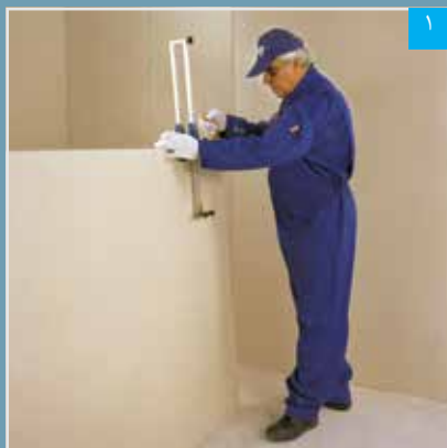
برش پنل با دستگاه برش طولی
