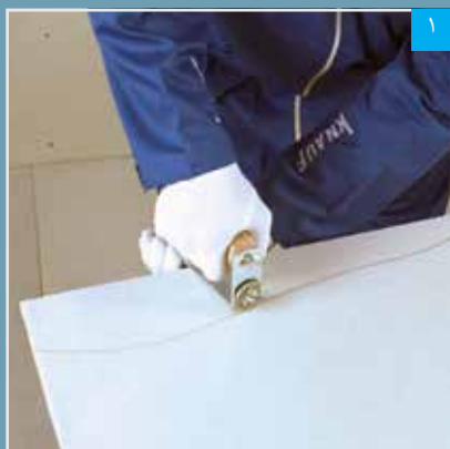
اجرای برش موج‌دار با دستگاه برش قرقراهی
