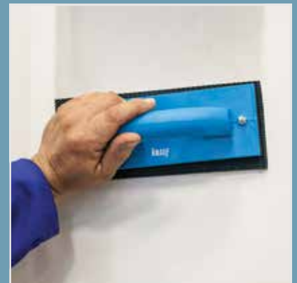
مرطوب کردن سطح دیوار با اسفنج نمدار
