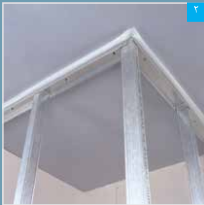
شکستن نوار چسب جداکننده پس از نصب سازه‌ها
