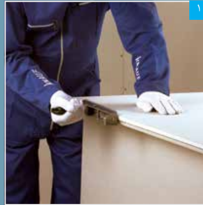
پرداخت لبه برش خورده با رنده
