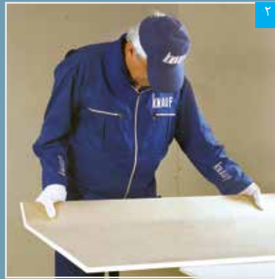
شکستن پنل در محل برش
