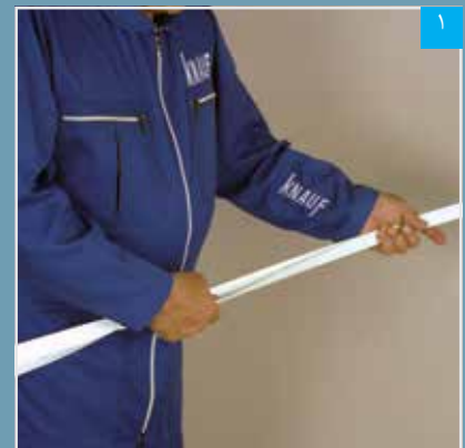
۱ خم کردن نوار درزگیر با دست
