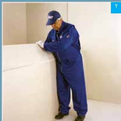
شکستن پنل در محل برش
