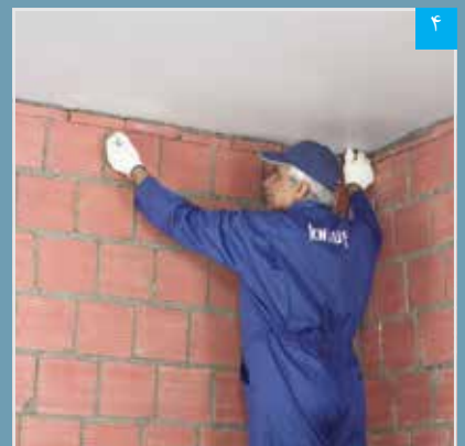
۴ علامت گذاری مسیر لایه پوششی بر روی سقف (با استفاده از ریسمان رنگی)
