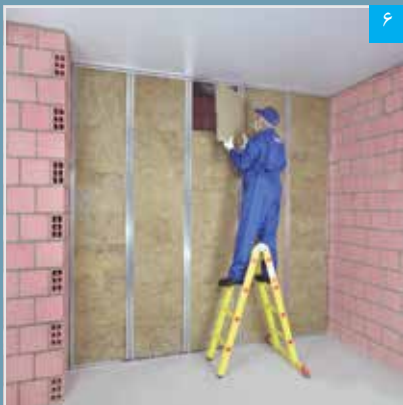
۶ اجرای عایق پشم معدنی (توجه: در فاصله میان استادهای)
