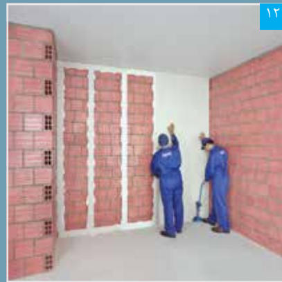
نصب پنل با استفاده از جک نگهدارنده
