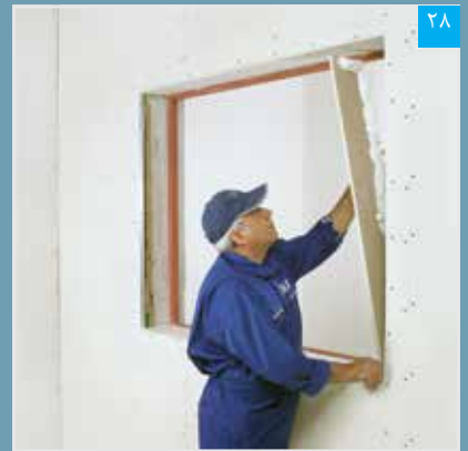
استقرار پنل نواری در ناحیه داخلی دور بازشوی پنجره (به اجرای یکپارچه پرفیکس توجه شود)
