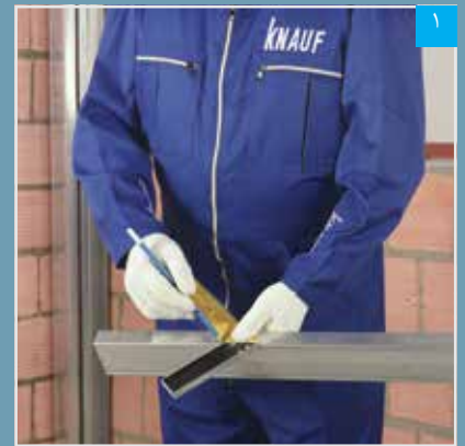
۱ علامت گذاری بر روی رانر قاب بندی بازشوی پنجره (به اندازه ۲۰ سانتیمتر و به صورت فارسی بر)
