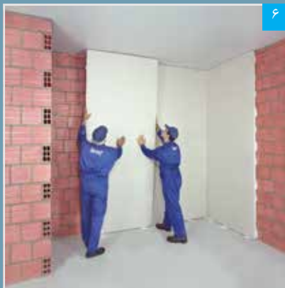
استقرار پنل بر روی دیوار زمینه
