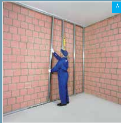
اجرای استاداها (به صورت شاقولی)
