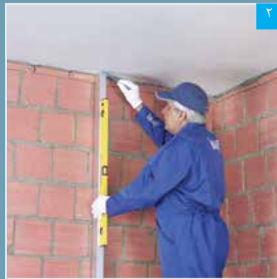
۲ شمشه گذاری بر روی دیوار زمینه، جهت تعیین ناترازی آن و علامت گذاری روی سقف
