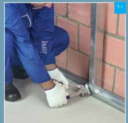
اتصال و تثبیت استاداها به رانرها (به وسیله پانچ، پرچ یا پیچ)
