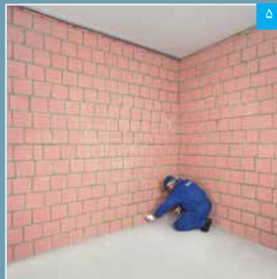
۵ مشخص کردن محل نصب سازه هادی کف با ریسمان رنگی
