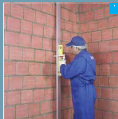
اندازه گیری میزان ناهمواری دیوار
