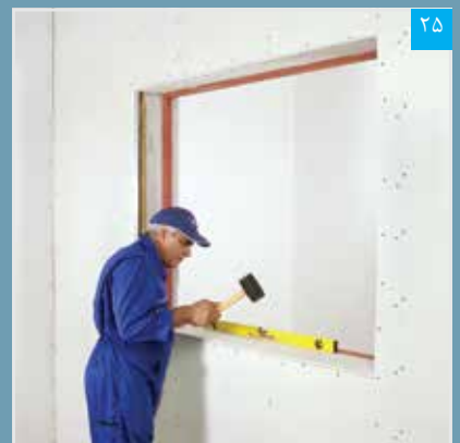
تنظیم پنل نواری (تراز کردن)
