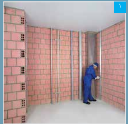
نصب اولین رانر بر روی ساختار جانبی
