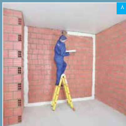
۸ اجرای پرلیکس به صورت نوار پیوسته در حاشیه پیرامونی دیوار زمینه
