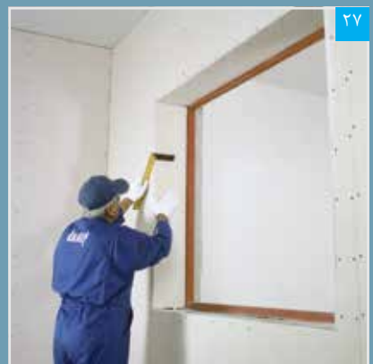
تنظیم پنل نواری (گونیا کردن)
