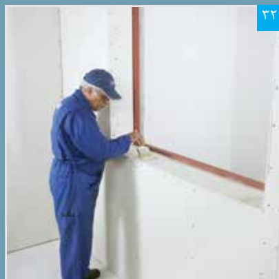
اجرای پرایمر بر روی سطح پنل
