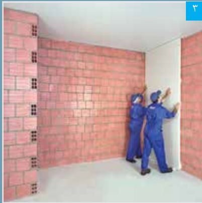
استقرار پنل بر روی دیوار زمینه
