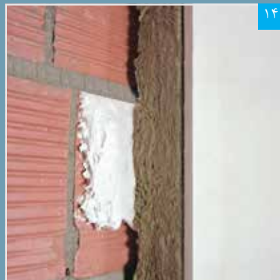
ضخامت چانه پرفلیکس پس از نصب و فشردن پنل باید حداقل ۵ میلیمتر باشد
