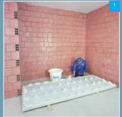
اجرای چانه‌های پرلیکس بر پشت پنل مرکب PS
