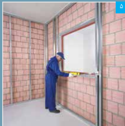
۵ تنظیم رانر قاب بندی تختانی به وسیله تراز
