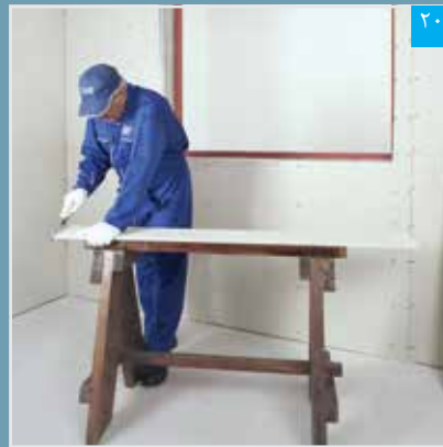
برش پنل نواری (برای پوشش کاری ناحیه داخلی دور بازشوی پنجره)
