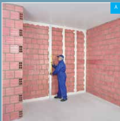
بررسی تراز و تنظیم بودن کرم نصب شده با استفاده از شمشه و تراز
