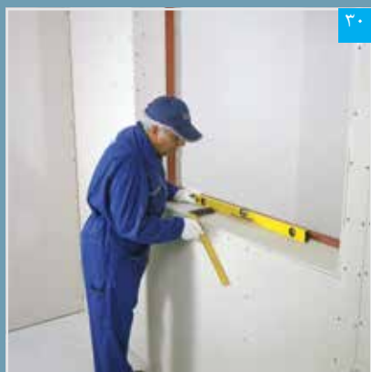
تنظیم پنل نواری (گونیا و تراز کردن)
