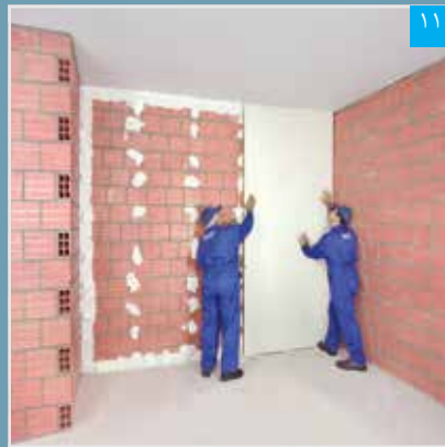
استقرار پنل بر روی دیوار زمینه
