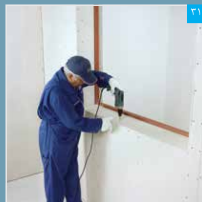
اتصال پنل نواری به رانر قاب بندی تحتانی
