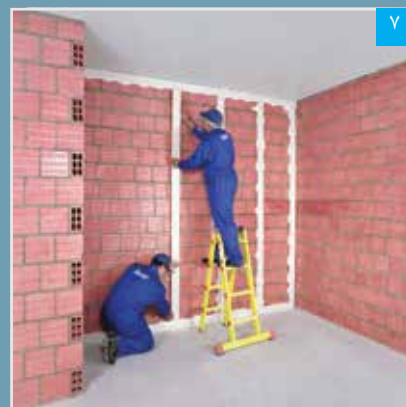
نصب کرم‌ها با فاصله حداکثر ۶۰ سانتیمتر از یکدیگر (مرکز به مرکز)
