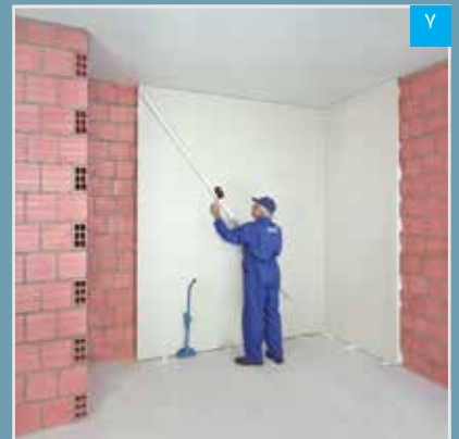
نصب و تنظیم پنل، با پنل نصب شده مجاور
