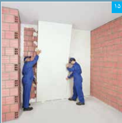
پنل‌ها بر روی محور مرکزی ردیف‌های پرفلیکس مستقر می‌شوند
