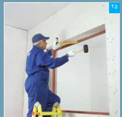
تنظیم پنل نواری (گونیا کردن)
