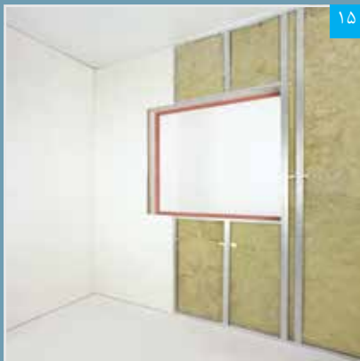
در محل بازشوی پنجره، برش پنل به صورت «C» شکل صورت می‌گیرد
