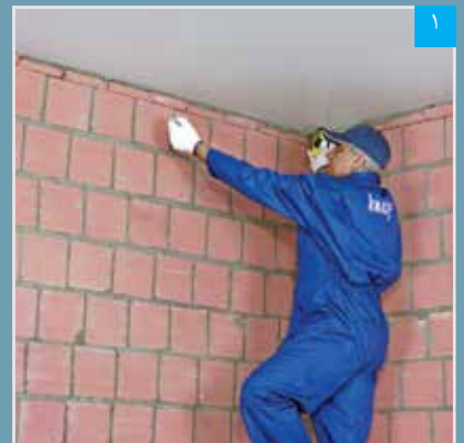
۱ مشخص کردن محل نصب رانر سقف با ریسمان رنگی
