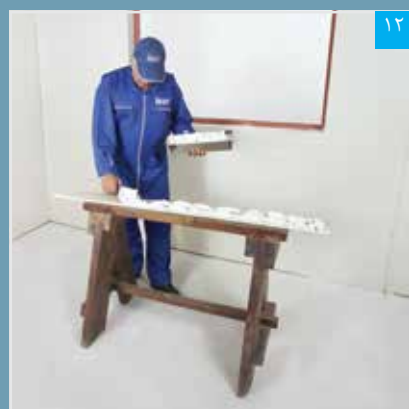
اجرای پرفیکس بر پشت پنل نواری (برای پوشش کاری ناحیه داخلی دور بازشوی پنجره)
