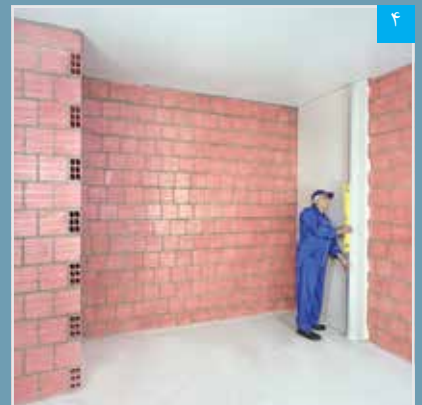
بررسی تراز و تنظیم بودن پنل نصب شده با استفاده از شمشه و تراز
