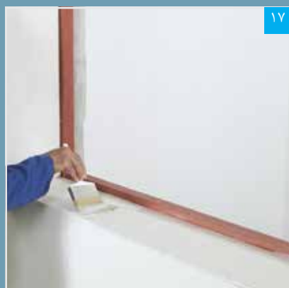
اجرای پرایمر بر روی سطح پنل
