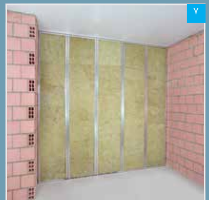
۷ لایه عایق تکمیل شده
