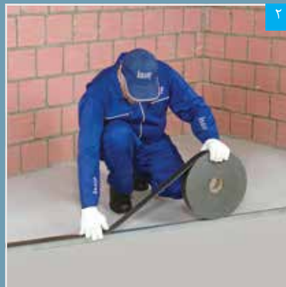
۲ اجرای نوار عایق (یا دو ردیف خمیر درزبند) بر پشت جان رانر کف و سقف
