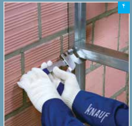
اتصال و تثبیت استاد به رانر (به وسیله پانچ، پرچ یا پیچ)
