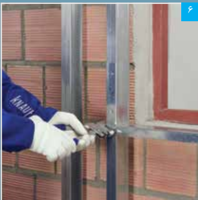
۶ اتصال رانر قاب بندی تختانی به استاد به وسیله پانچ، پرچ یا پیچ (به جهت برش ۴۵ درجه توجه شود)
