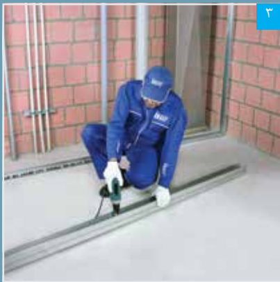
۳ اجرای استادهای دوتایی
