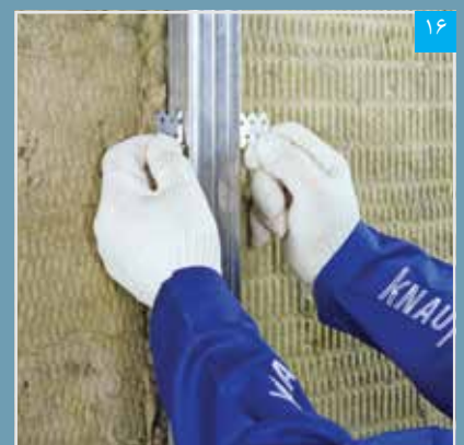
۱۶ خم کردن طول اضافه بال‌های براکت (توجه: لایه عایق در پشت سازه‌ها قرار می‌گیرد)
