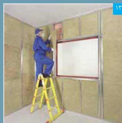
۱۳ اجرای عایق پشم معدنی
