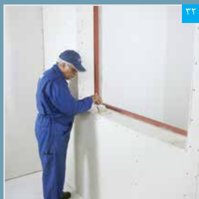
اجرای پرایمر بر روی سطح پنل
