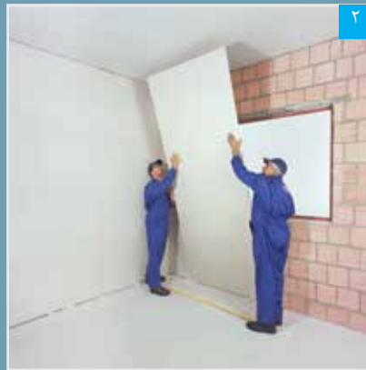
استقرار پنل بر روی دیوار زمینه
