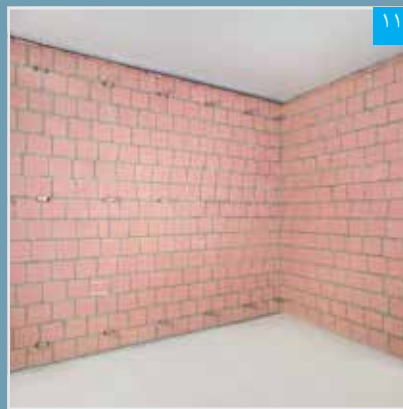
۱۱ براکت‌های نصب شده
