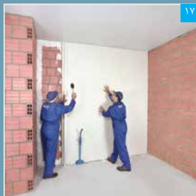
تنظیم نهایی پنل نصب شده با شمشه و چکش لاستیکی
