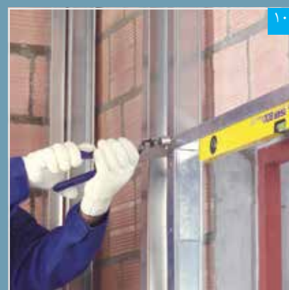
۱۰ اتصال راتر قاب بندی فوقانی به استاد به وسیله پانچ، پرچ یا پیچ (به جهت برش ۴۵ درجه توجه شود)
