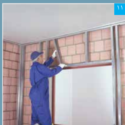
۱۱ استقرار استاداها در راتر سقف و راتر قاب بندی فوقانی
