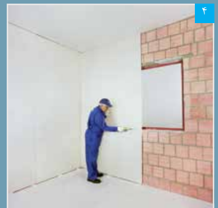
برش پنل با استفاده از اره
