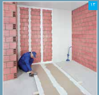
لایه نواری بتونه درزگیر را می توان بر پشت پنل ها اجرا نمود
