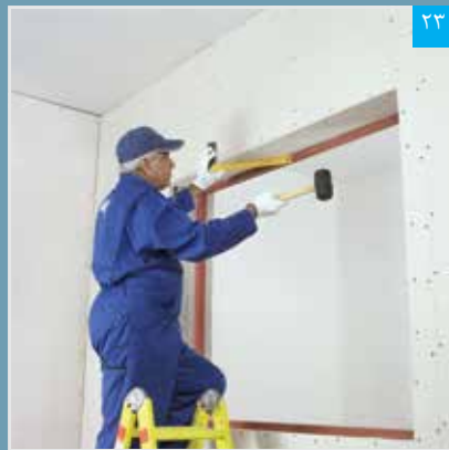
تنظیم پنل نواری (گونیا کردن)
