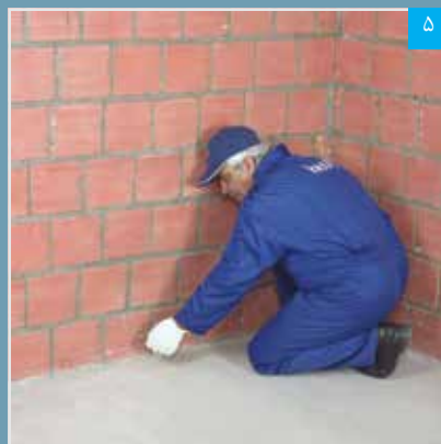
۵ علامت گذاری مسیر لایه پوششی بر روی کف (با استفاده از ریسمان رنگی)
