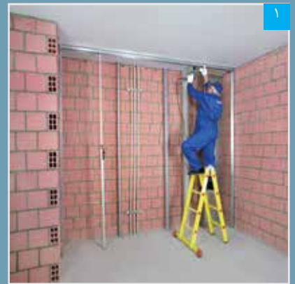
۱ اجرای قاب پیرامونی (به روش مشابه ساختار W625)
