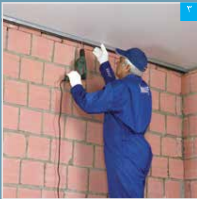
۳ نصب سازه هادی سقف
