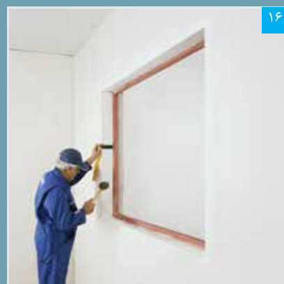
نصب و تنظیم پنل نواری
