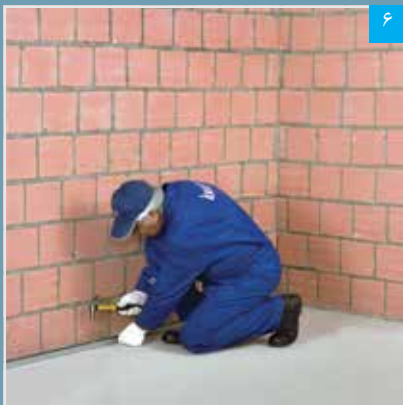
۶ نصب سازه هادی کف
