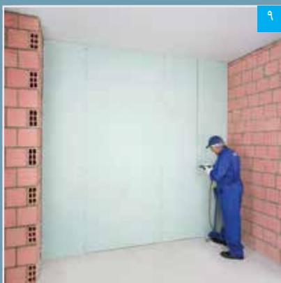
۹ نصب لایه دوم پنل‌ها و تکمیل ساختار
