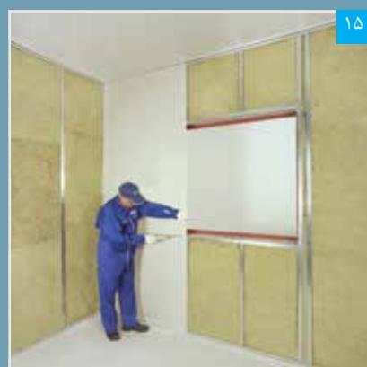
۱۵ برش پنل با استفاده از اره
