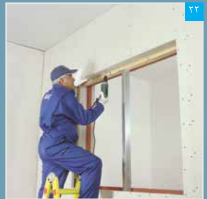
اتصال پنل نواری به سازه قاب بندی فوقانی
