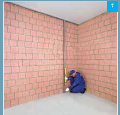
۴ انتقال تصویر سازه هادی سقف به کف (با استفاده از استاد و تراز)
