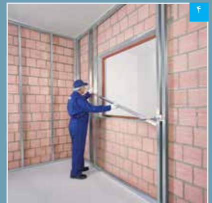
۴ استقرار رانر قاب بندی تختانی (به جهت خمها توجه شود)
