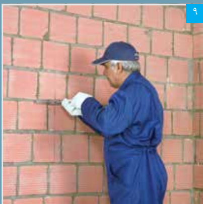
۹ نصب براکت بر روی دیوار زمینه
