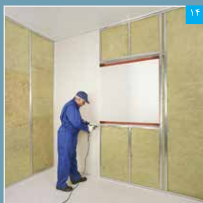
۱۴ نصب پنل بر روی زیرسازی
