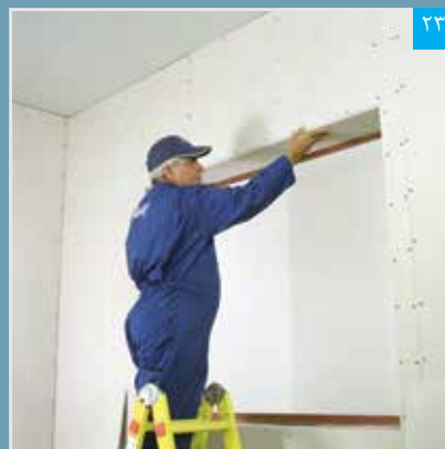
تنظیم لبه های پنل در محل کنج
