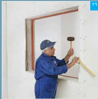
تنظیم پنل نواری (گونیا کردن)
