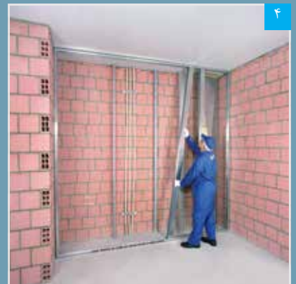
۴ استقرار استادهای دوتایی در رانرها (به صورت شاقولی)
