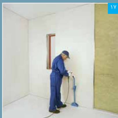
۱۷ نصب پنل بر روی زیرسازی
