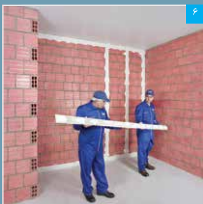
چانه‌های پرل‌فیکس در فواصل حداکثر ۳۵ سانتیمتر (مرکز به مرکز) بر پشت کرم‌ها قرار می‌گیرند
