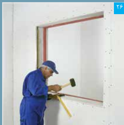
تنظیم پنل نواری (گونیا کردن)
