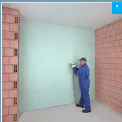
نصب لایه دوم پنل‌ها و تکمیل ساختار
