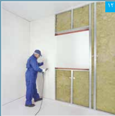
نصب پنل بر روی زیرسازی
