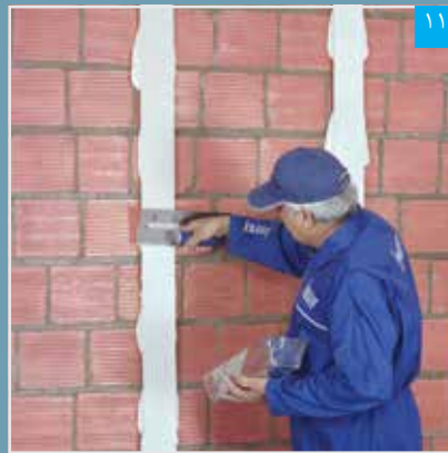
اجرای لایه بتونه درزگیر بر روی کرم ها با استفاده از ماله دندانه دار
