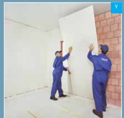
استقرار پنل بر روی دیوار زمینه
