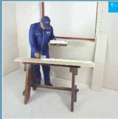
اجرای پرفلیکس بر پشت پنل نواری (برای پوشش کاری ناحیه داخلی دور بازشوی پنجره)
