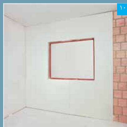
پوشش کاری تکمیل شده در ناحیه بیرونی بازشوی پنجره
