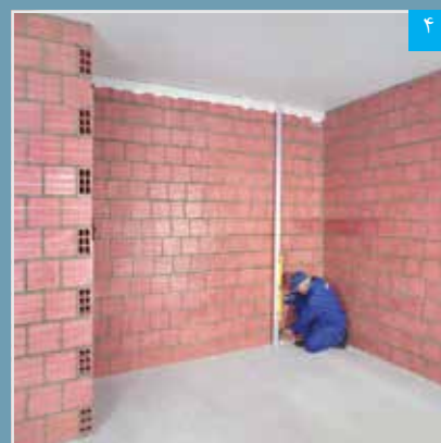
مشخص کردن محل نصب کرم پایین با استفاده از شمشه و تراز
