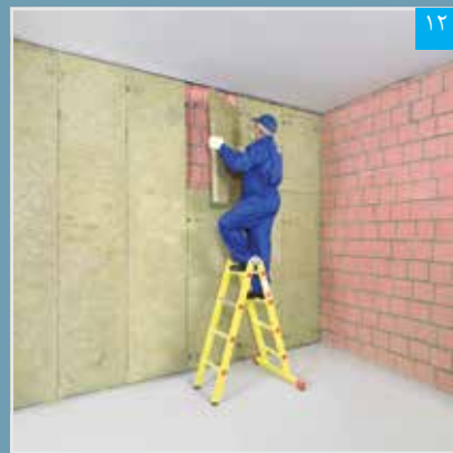
۱۲ اجرای عایق پشم معدنی
